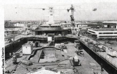
LE « SOVEREIGN OF THE SEAS » SUR LE CHANTIER DE SAINT-NAZAIRE
