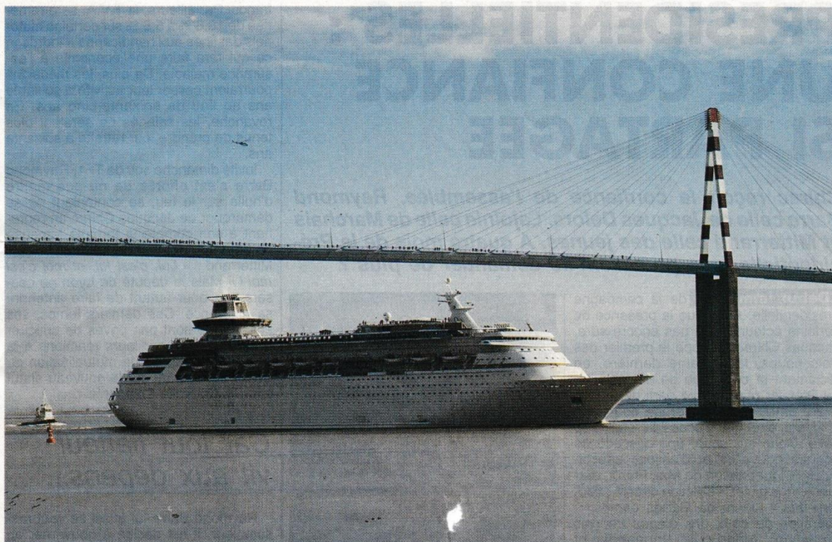
Sous le pont de Saint-Nazaire. Une petite dizaine de mètres sépare le haut de la cheminée du bateau du tablier du pont.
